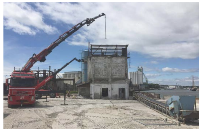
Nedrivning af Mørtelværket, 2016
