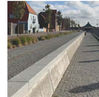
Grantelementer på Nordkajens højvandsmur
