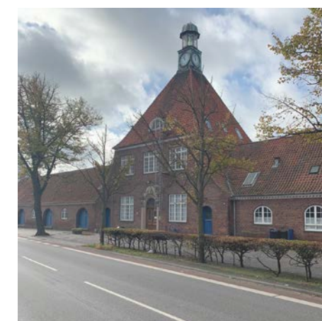
Oprindelig flankerede to lindetræer Havnebygningens midterparti
