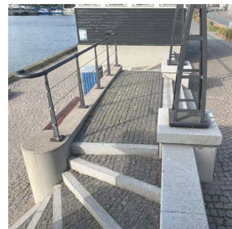
Højvandsikring - Trappeanlæg med barrierevirkning
